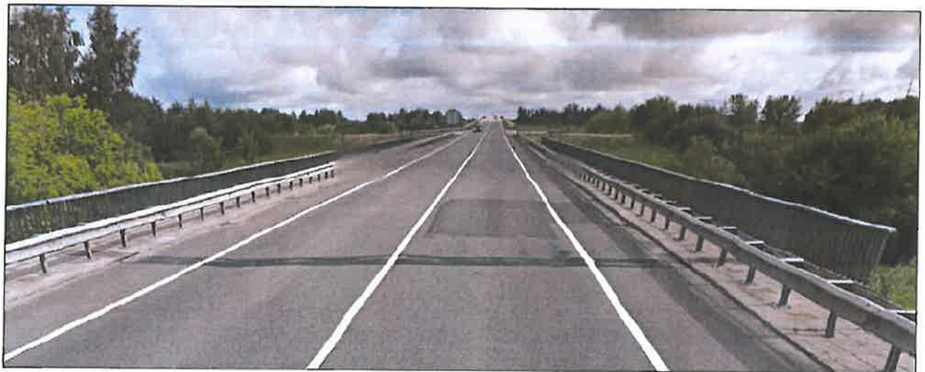
7. pav. Tiltas per Nevėžio upę Pk 117+80
